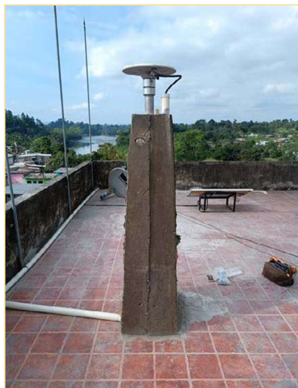
Figura 4. Estructura de la estación de monitoreo continuo en Quinindé
