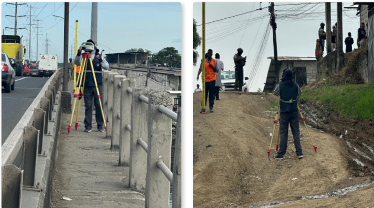
Figura 25. Operadores del proceso de geodesia durante la nivelación geométrica contratada por la empresa INTERAGUA
