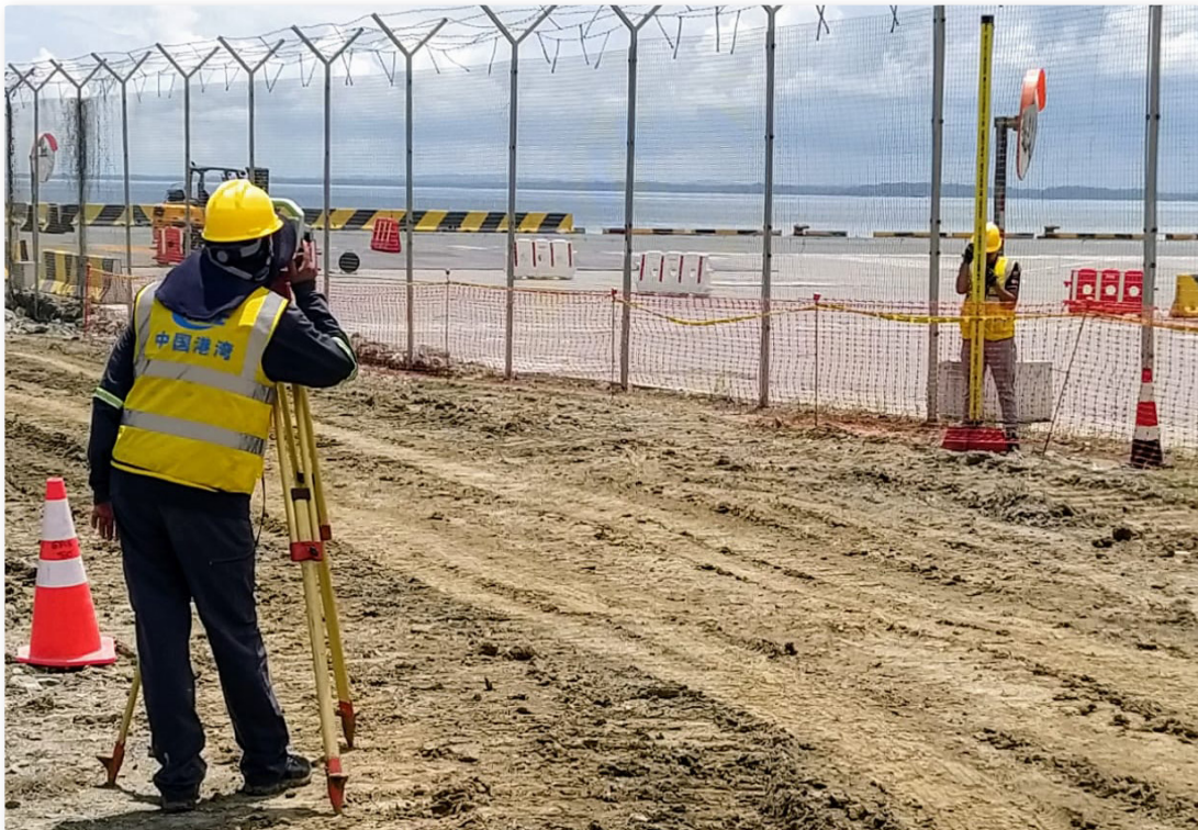
Figura 23. Técnico del proceso de Geodesia realizando la nivelación geométrica en los terrenos de la empresa CHINA HARBOUR ENGINEERING COMPANY
